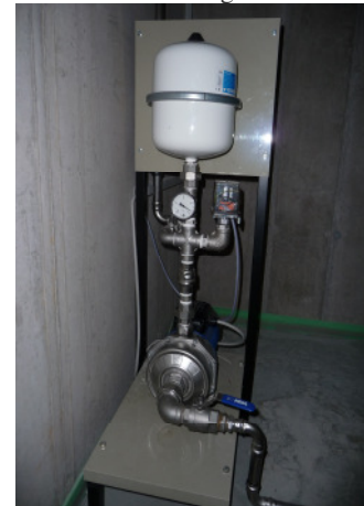
Druckerhöhungsstation
